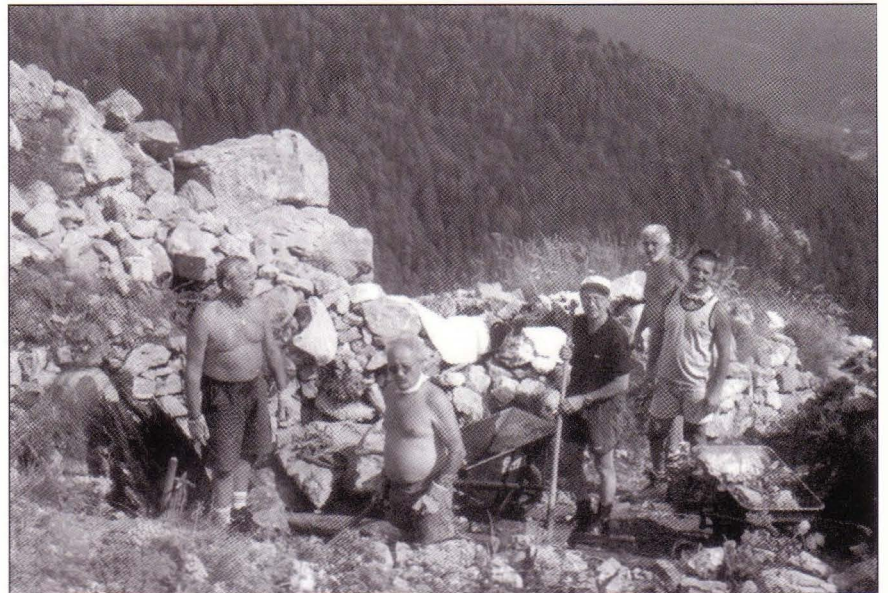
Durante i lavori di scavo
